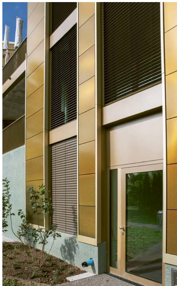
Die PV-Elemente liegen hinter goldenen Glaspanelen und sind sie von blossen Auge nicht erkennbar. Durch die leicht goldig schimmernden Glasstreifen entsteht ein subtiles Spiel mit Reflexionen und der Spiegelung der Umgebung.
